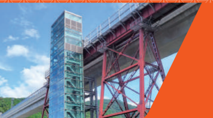
高さ40mの崖を横断する鉄橋
